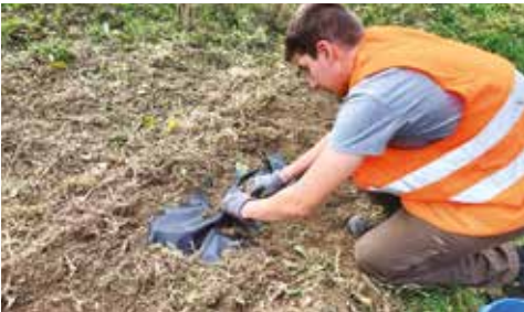
5. Riempimento manuale delle buche e compattamento del suolo
